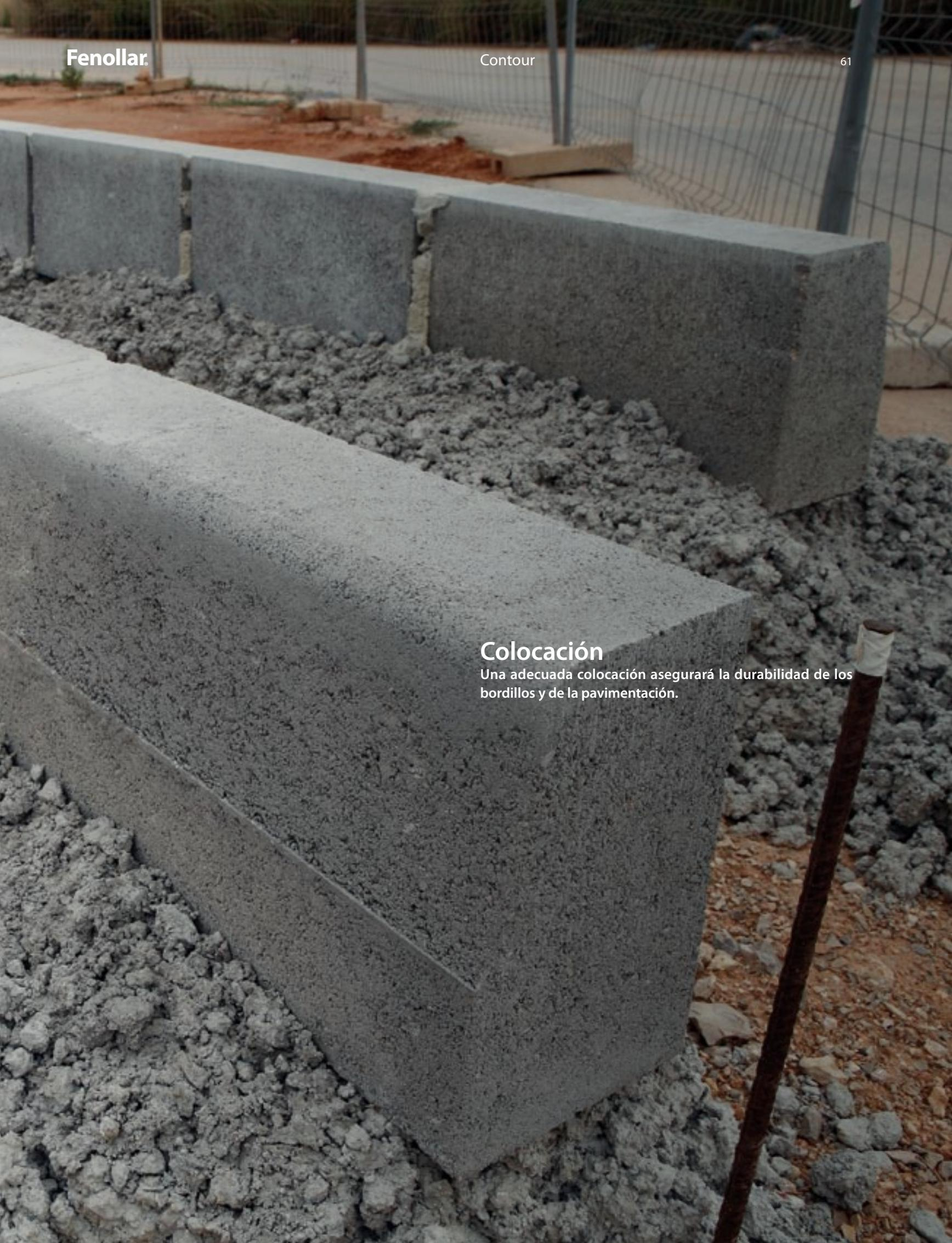
Normalmente, la colocación de los bordillos es previa a la ejecución de los pavimentos que delimita, especialmente en casos de firmes flexibles o adoquinados. En el caso de que el paso de maquinaria pudiera deteriorar la obra ya ejecutada o la estabilidad del bordillo, se dispondrán cuñas o contrafuertes de hormigón en el trasdós para garantizar esta, o se acotará la zona para evitar esos deterioros.
